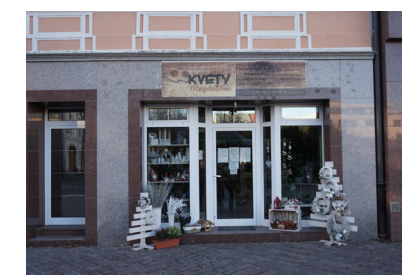
2. Príklad nečitateľného nápisu obsahujúceho zbytočne veľa informácií, ktorý zároveň prekrýva architektonické prvky budovy.
